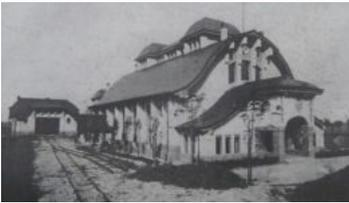
Der Abtransport der Feststoffe erfolgte mit Loren, die mit Wassergewichten in eine höhere Ebene gezogen wurden, von dort aus rollten sie bergab zur Verladung. Die vorab gefilterten Stoffe wurden mit der Hallenkrananlage gehoben und mit Loren zur Verladung gebracht. Landwirte kauften dieses Material als Dünger für die Felder an. Die Düngerproduktion in Krefeld hat also Tradition.
